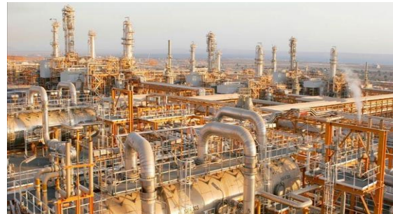
Gas Refineries and LNG Units
